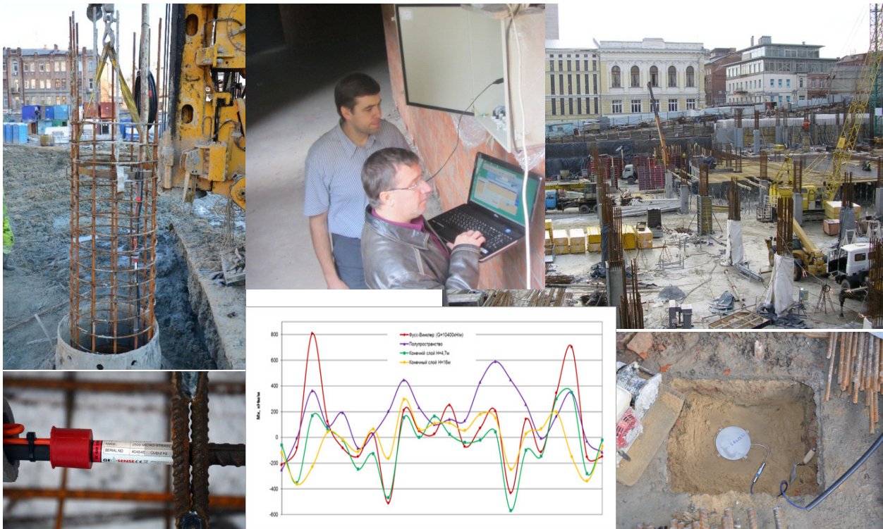
Рис. 7. Інструментальний моніторинг напружено-деформованого стану системи «основа — пальово-плитний фундамент — споруда»
